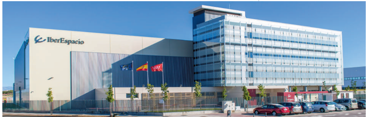
Instalaciones de IberEspacio en Torrejón de Ardoz
